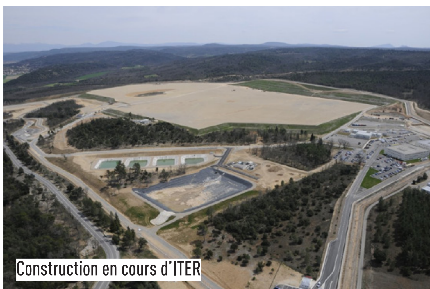
Réunion d'information sur les marchés futurs du nucléaire : projet expérimental ITER International à Cadarache et maintenance des centrales.
